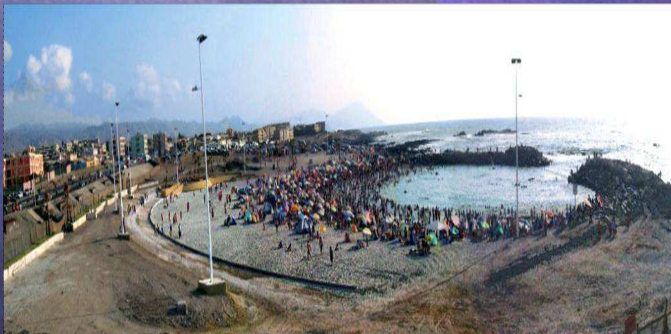
Mejoramiento Balneario Trocadero Antofagasta
